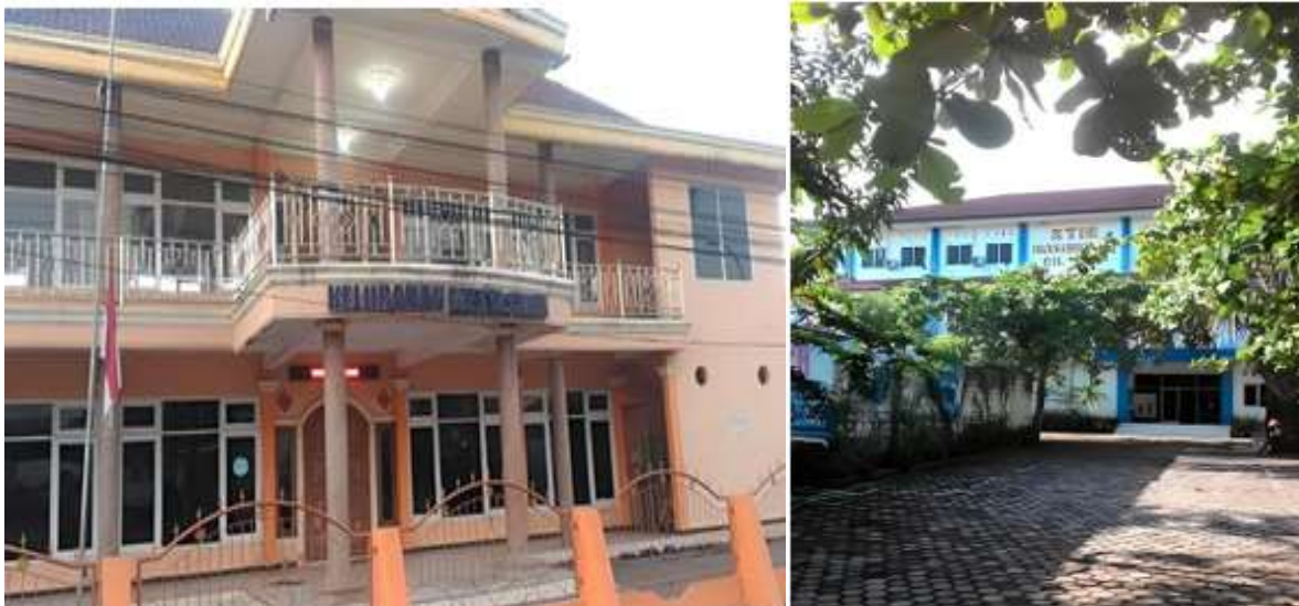
Gambar 4. Gedung Evakuasi Sumber: Dokumentasi Penelitian
