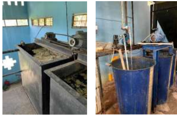
Gambar 4. Gedung IPL (a) Bak Koagulasi dan (b) Flokulasi
