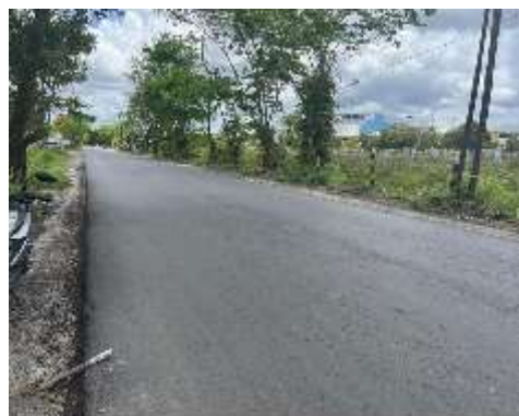
Gambar 6. Segmen 2 Kondisi Jalan Baik (STA 1+300 - 1+400) Sumber: Dokumentasi Penulis (2025)
