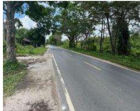
Gambar 4. Segmen 1 Kondisi Jalan Baik (STA 0+700 - 0+800) Sumber: Dokumentasi Penulis (2025)
