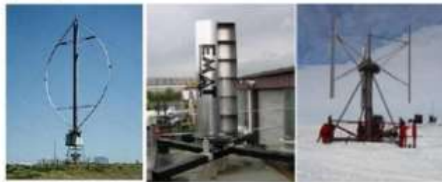
Gambar 4. Jenis-jenis turbin angin sumbu vertikal [21]
