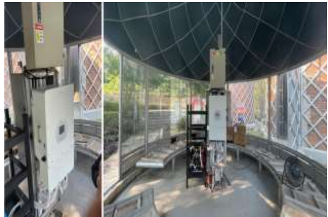
Gambar 9. Pemasangan Inverter dan Baterai
