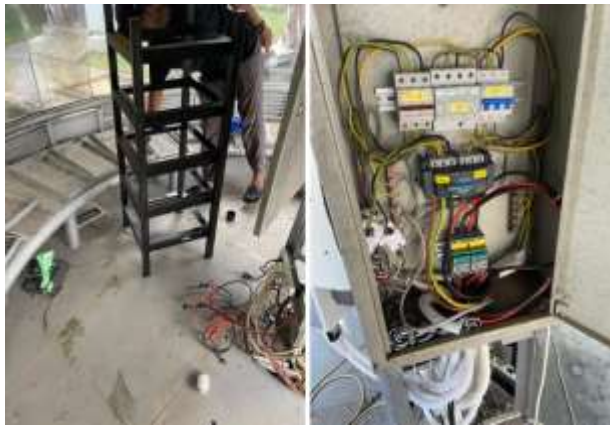
Gambar 8. Pemasangan Inverter Hybrid SCC
