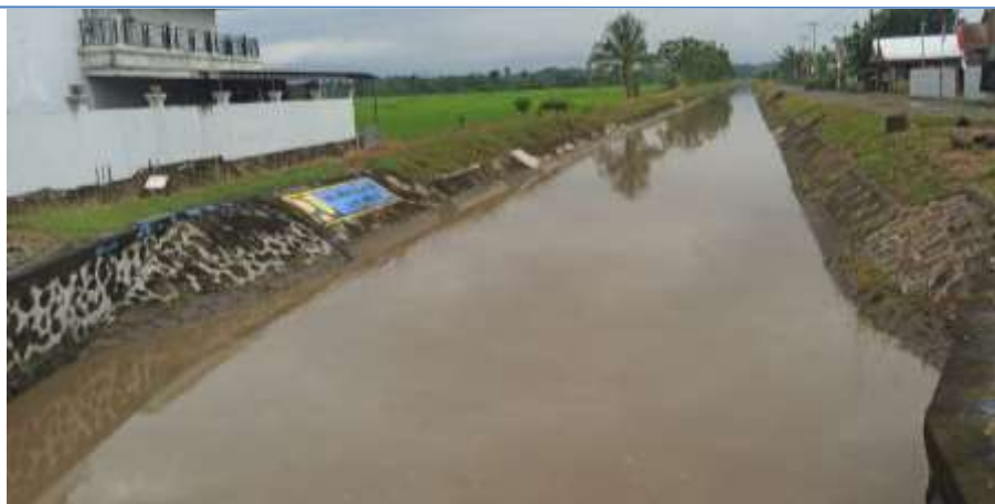
Gambar 2. Saluran irigasi Bangunan Bila Kiri
