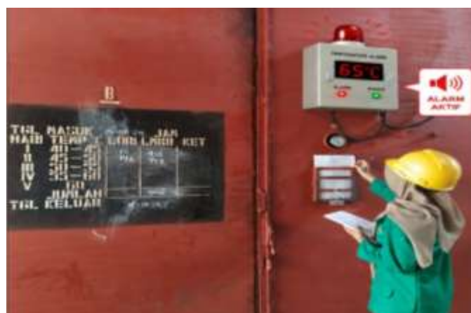
Gambar 8. Usulan Pemasangan Temperature Alarm pada Proses Pengasapan RSS Sumber : Pengolahan Data, 2026
