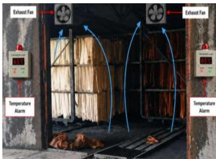
Gambar 6. Usulan Pemasangan Exhaust Fan pada Kamar Asap
