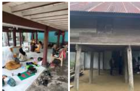
Gambar 9. Lantai Kolong Rumah Sudah Menggunakan Keramik dan yang Masih Berlantai Tanah Sumber: Hasil Survey, 2024
