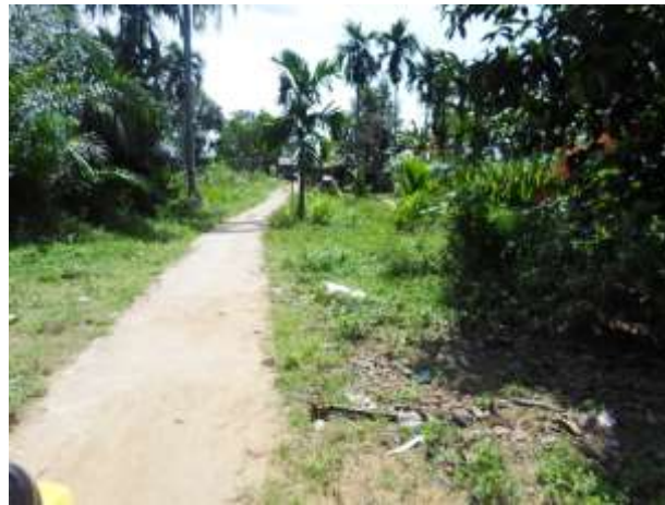
Gambar 3. Kondisi jalan desa
