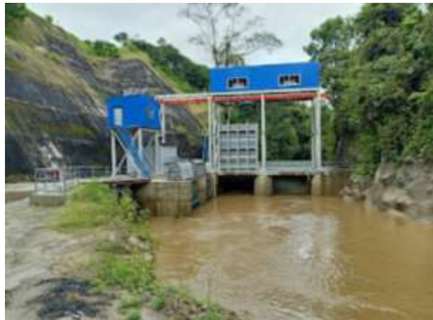
Gambar 4. Kondisi bangunan bendung PLTM Karo Bumi Energi
