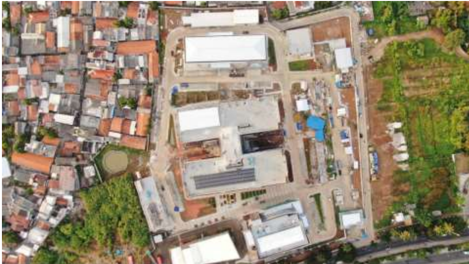
Gambar 5. Perkerasan dalam tapak Fasilitas Research & Technology Center Pertamina Sumber: Dokumentasi pribadi
