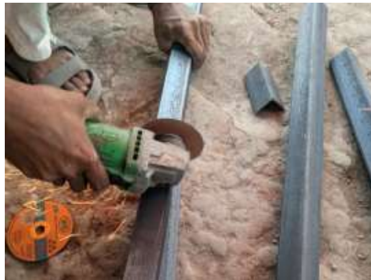
Gambar 2. Proses Pengukuran dan Pemotongan Sumber: Analisa Data Pada Lapangan
