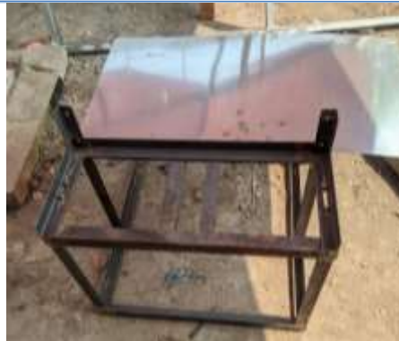
Gambar 4. Pemasangan Plat Stainless Sumber: Analisa Data Pada Lapangan
