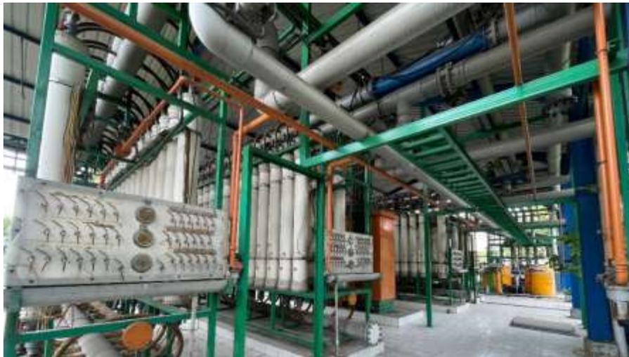
**Gambar 2.** Rangkaian Membran Ultrafiltrasi Perumda Air Minum Sidoarjo
