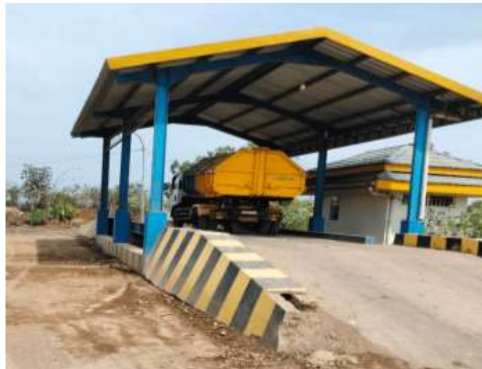
Gambar 3. Jembatan Penimbangan Sampah TPAS Sekoto Sumber: Peneliti, 2024
