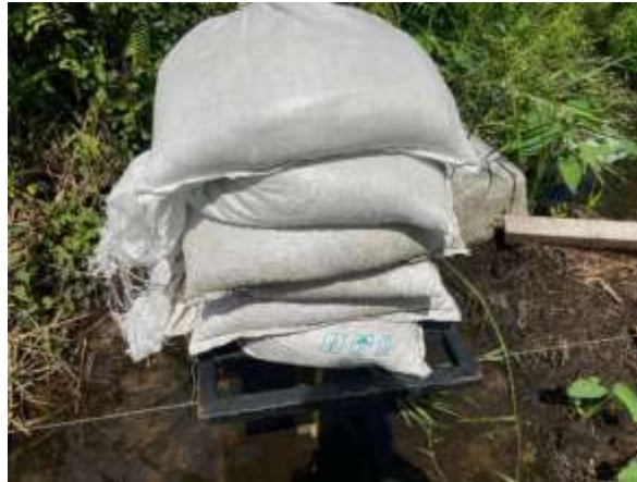
Gambar 7. Proses Pengujian Pembebanan di Lapangan
